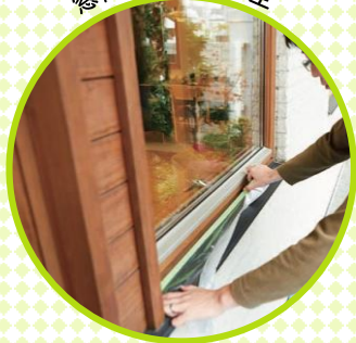
窓枠塗装前の養生
